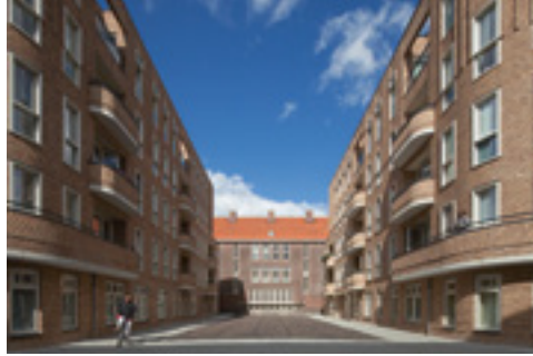
Kraaipanschool Ymere ontwikkeling Architectenbureau Hoogeveen bv Stadsdeel Oost Fotografie: Luuk Kramer
